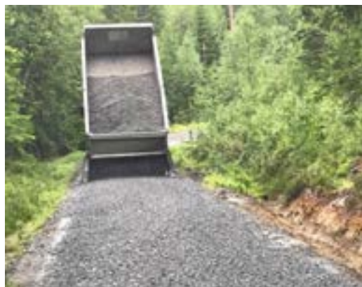
Utbedring av veien. Foto: Hytteutvalget
