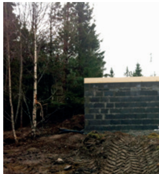
Byggearbeider på Sjøhaugen.
